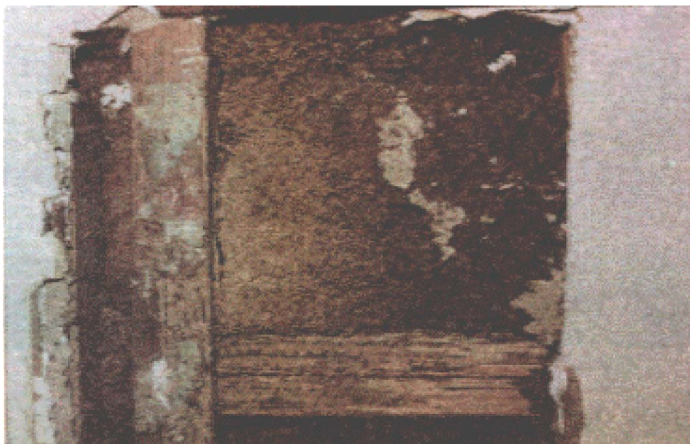
(d) Workings of Coptotermes acinaciformis in a stud wall
